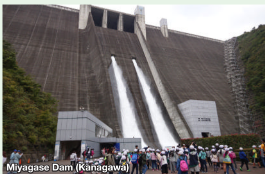
Miyagase Dam (Kanagawa)
